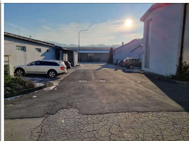
Zpevněné plochy v areálu
