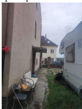
vstup do domu ve štítové stěně
