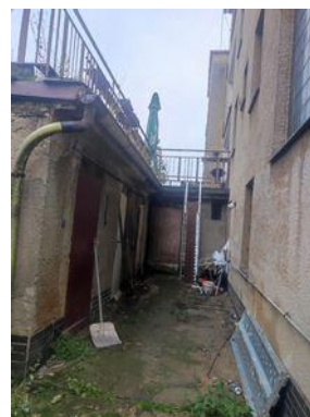
budova sklepů a dvůr
