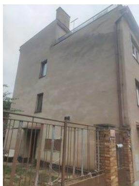
vjezd a štít domu
