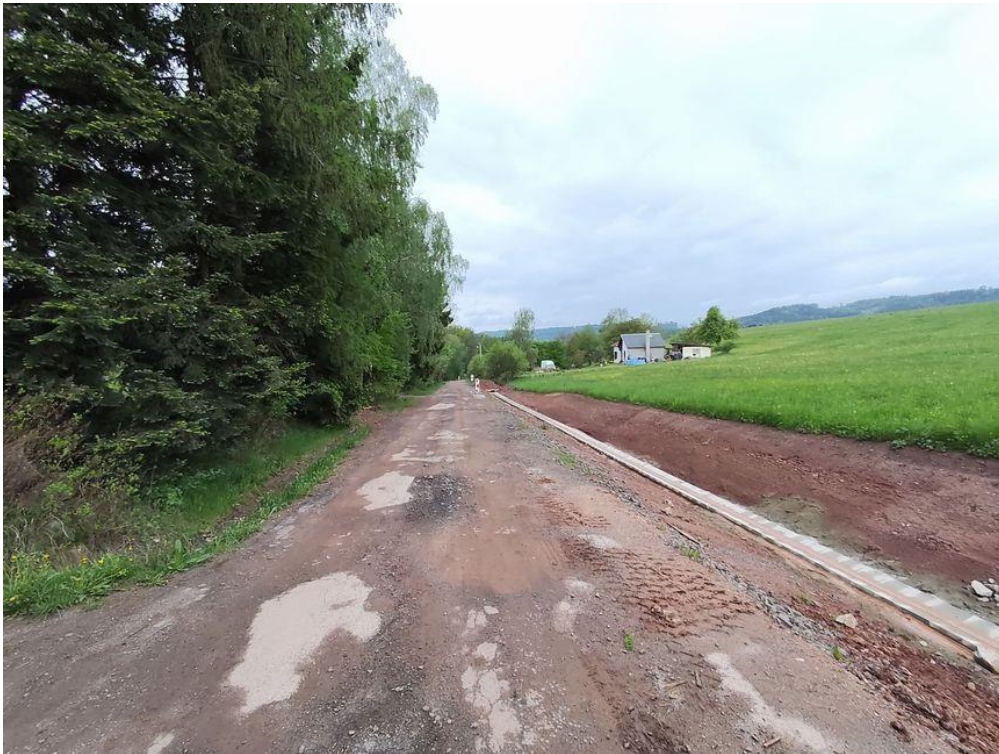
příjezd k nemovitosti po hl.komunikaci
