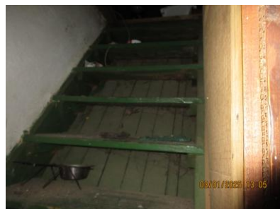
Schodiště do půdního
