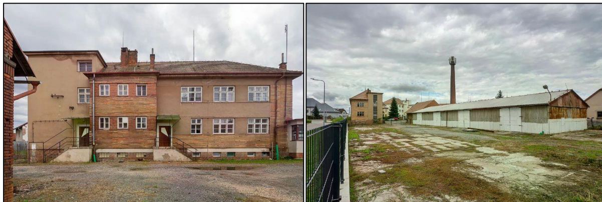
Obrázek č. 7 – Srovnávací nemovitost č. 1
