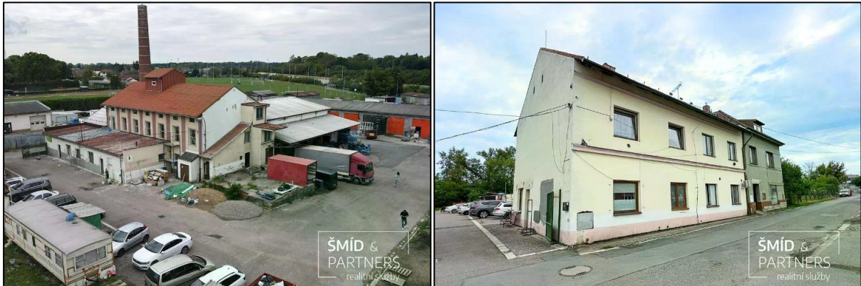
Obrázek č. 9 – Srovnávací nemovitost č. 3
