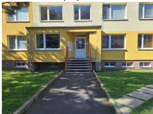
Vstupu do domu sekce č.p. 80
