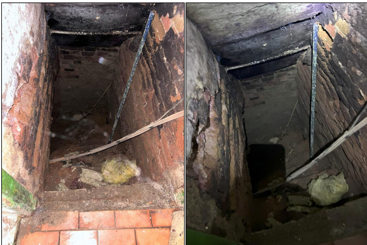
Sklep domu č.p. 7, Ruda nad Moravou
