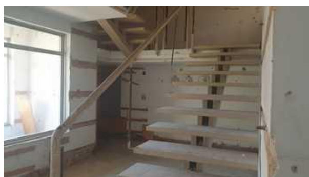
centrální schodiště do 2.NP
